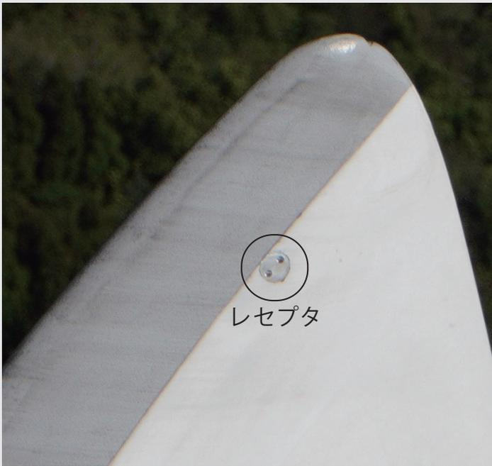
ブレード先端(レセプタ拡大画像)
